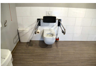
Toilette für Alle – Yukon Bay
