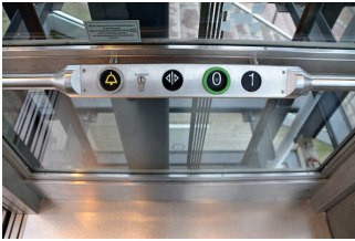
Außenaufzug am "Rudolf-von- Bennigsen-Ufer"
