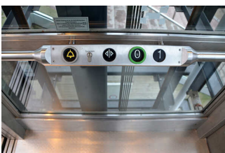
Außenaufzug am "Rudolf-von- Bennigsen-Ufer"
